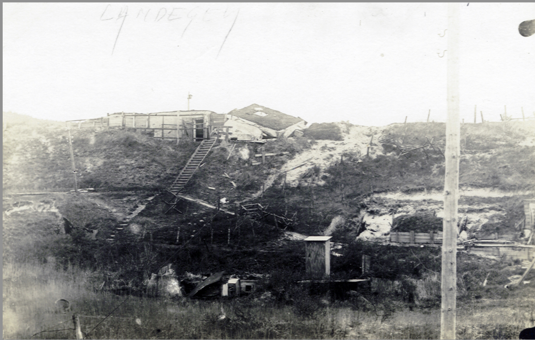
Landegem, puinen van de confituurfabriek Haesaert
