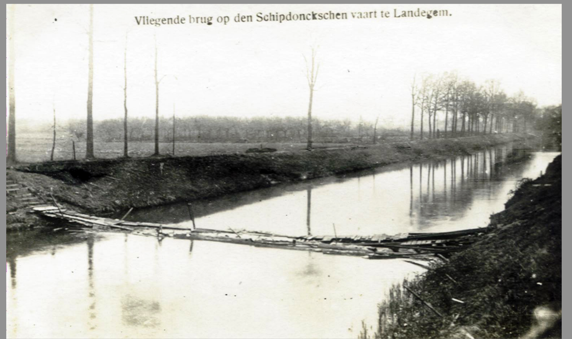
Een passergelle over het kanaal in Landegem
