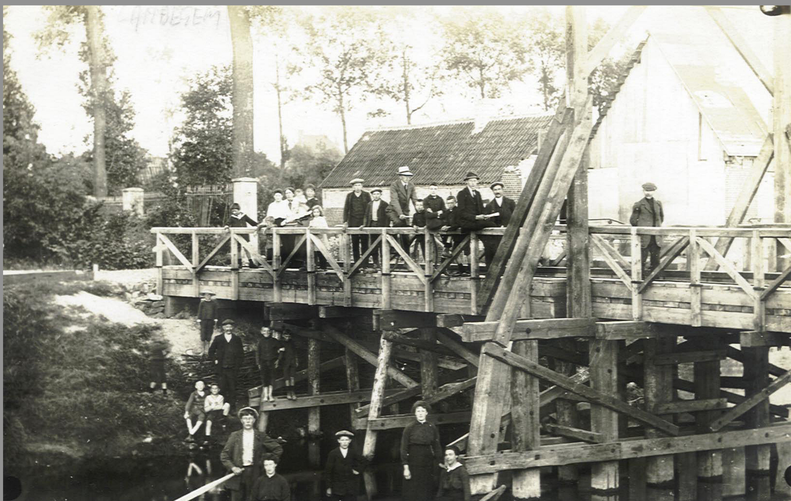
De voorlopig herstelde vaartbrug in Landegem
