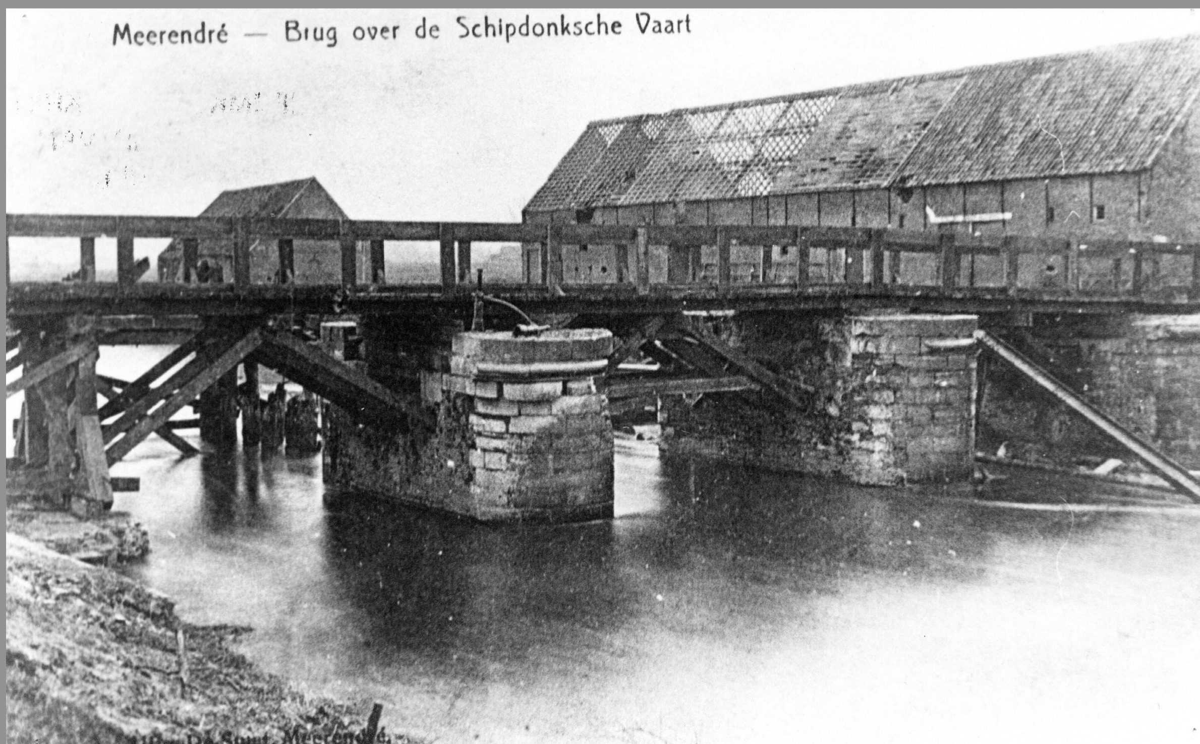
De voorlopig herstelde Kalebrug in Merendree
